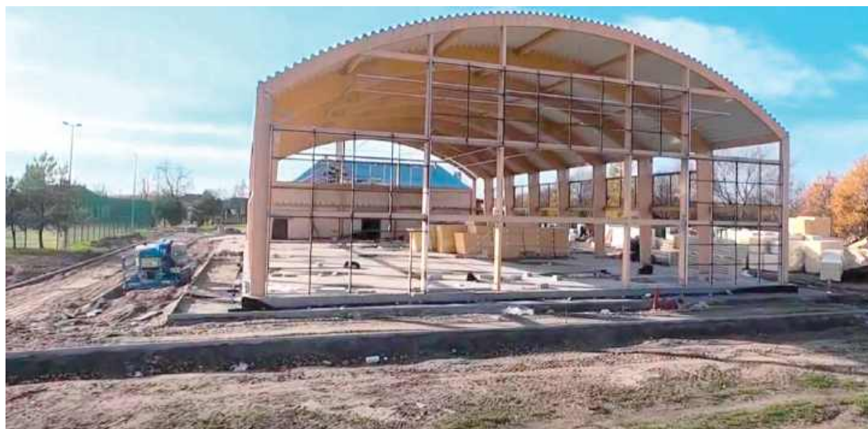
Powstała już konstrukcja dachu
