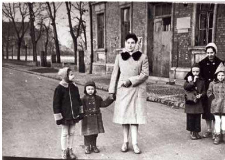
Nowosolanie przed dość zdewastowanym jeszcze budynkiem MOSiR w latach 50. (fot. Nowa Sól wczoraj)
