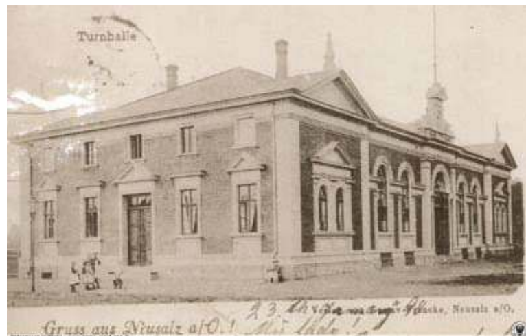
Turnhalle, dzisiejszy MOSiR, powstała w 1895 roku, w latach 50. budynek przybrał dzisiejszy kształt
