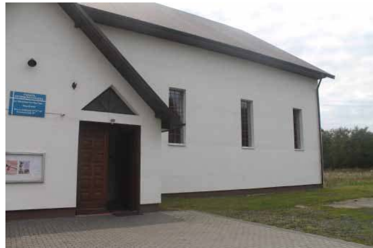
Wejście na salkę zostanie zrobione pod trzecim oknem
