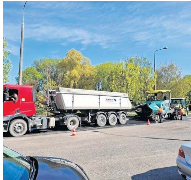
Na początku ulicy Okulickiego, tuż przy rondzie księdza Kotlarza, trwa układanie warstwy ścieralnej.
