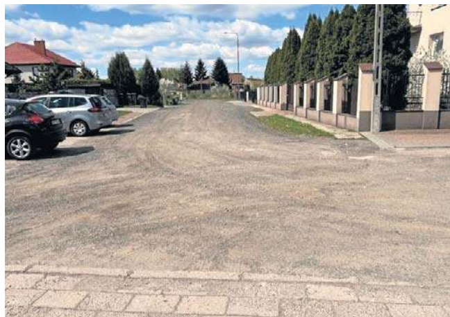
Odcinek ulicy Niemcewicza w Radomiu zostanie przebudowany.
