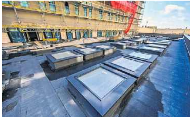
Prace na budowie wstrzymano w 2024 roku
