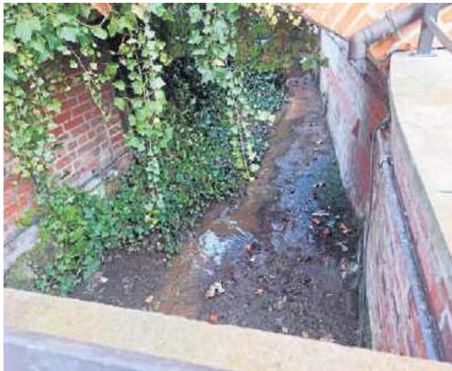
Suchy kanał A Strugi Toruńskiej w centrum Torunia - przy ulicy Przedzamcze
