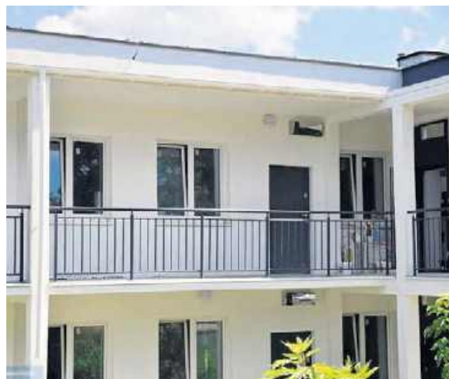
Przy ulicy Toruńskiej powstał blok socjalny, do którego mieszkańcy wprowadzili się jesienią 2024 roku. Trwa budowa kolejnego
