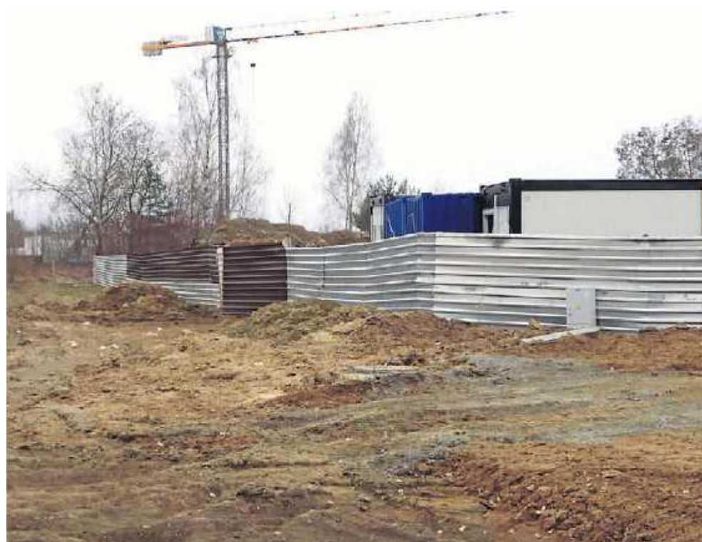
Plac budowy dwóch bloków przy ul. Lisiej na Rządzu. Pogoda na razie zastopowała prace
