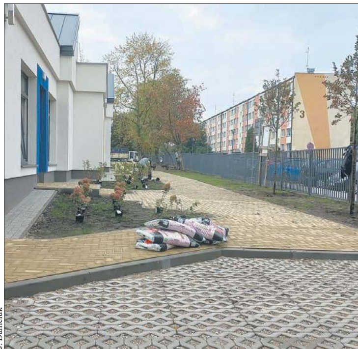
Rozpoczęły się nasadzenia drzew i krzewów przy nowym budynku przedszkola nr 17
