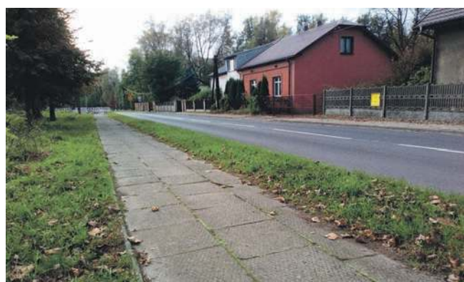
Remont chodnika przy ul. Słowackiego sfinansują po połowie gmina i powiat
