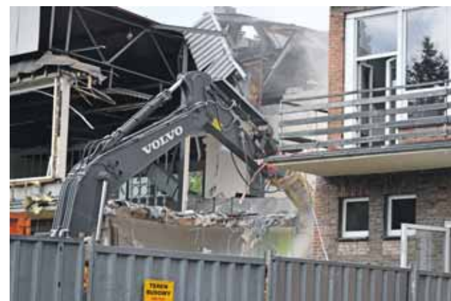
Duża inwestycja zaczyna się od demolki
