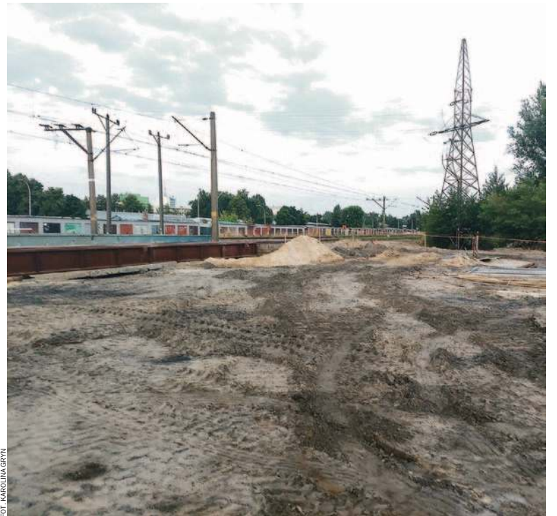
Prace nad budową łącznika mają trwać ponad rok
