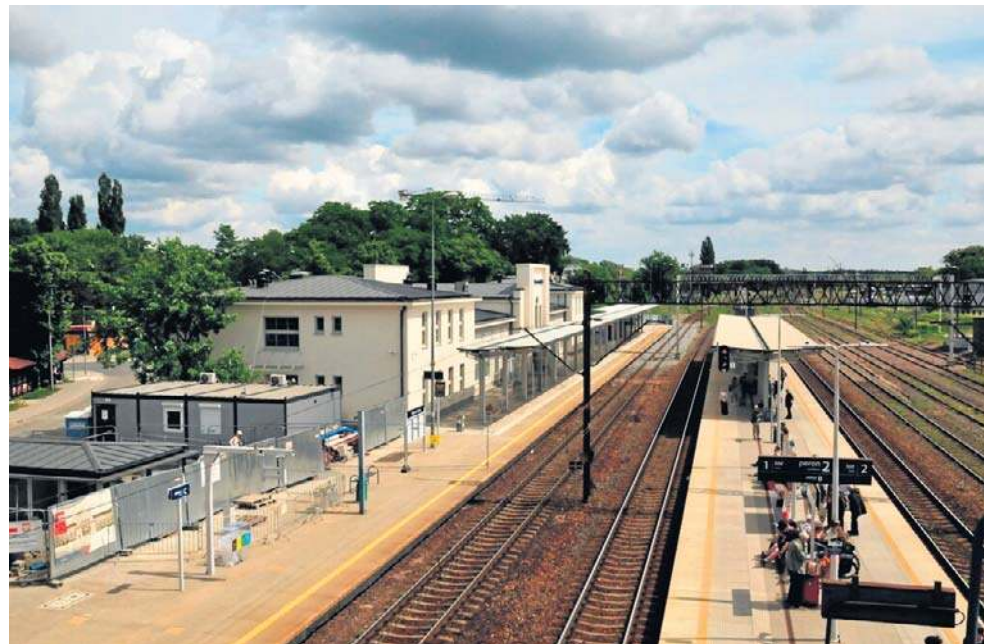
Tak wygląda obecnie wiata na 2 peronie. Jest znacznie oddalona od kładki, za to tuż przy nowym przejściu podziemnym. Szkoda, że PLK nie pomyślały o długiej wiacie
