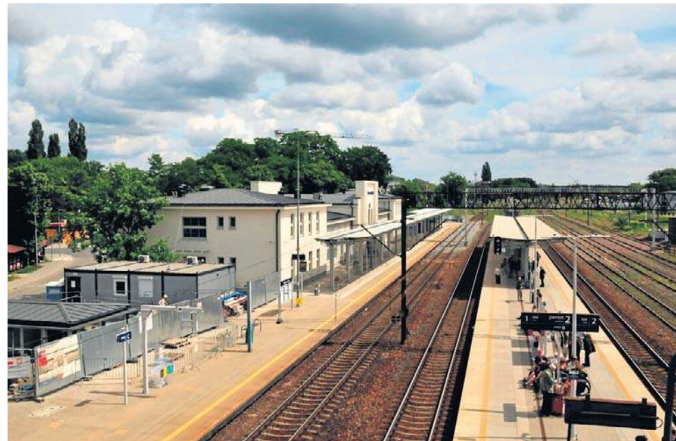
Tak wygląda obecnie wiata na 2 peronie. Jest znacznie oddalona od kładki, za to tuż przy nowym przejściu podziemnym. Szkoda, że PLK nie pomyślały o długiej wiacie
