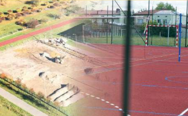
Boisko przy SP8 (w trakcie)
