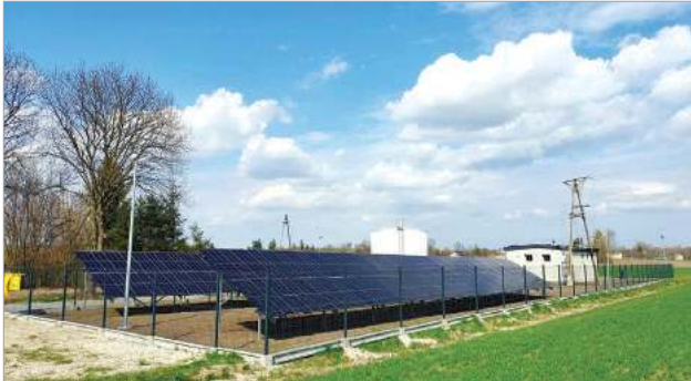
Zmodernizowane ujęcie wody w Białopolu
