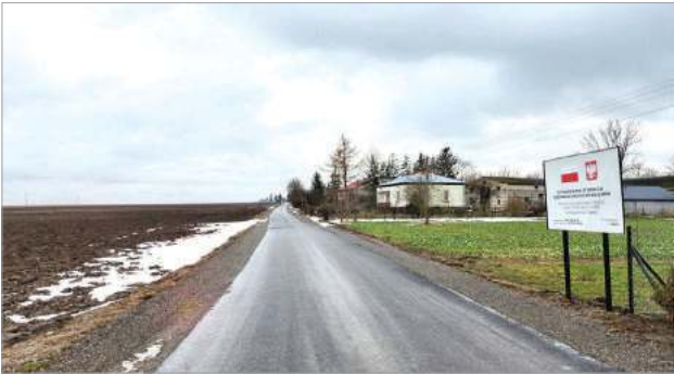
Zmodernizowana droga gminna w Teresinie
