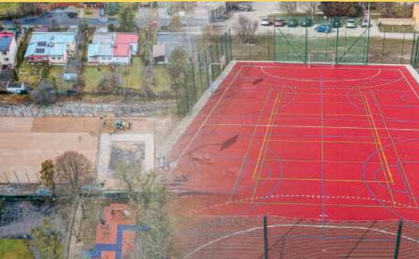
Boisko przy SP5 (w trakcie)
