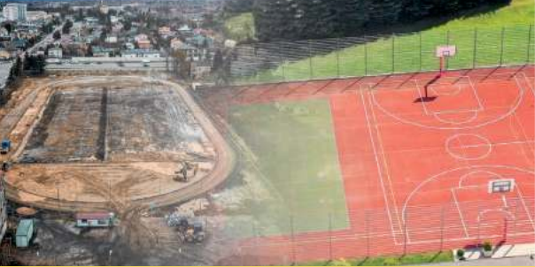
Stadion lekkoatletyczny (w trakcie)
