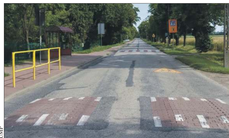
Będzie remont ulicy Sierpeckiej za blisko 7,5 mln zł
