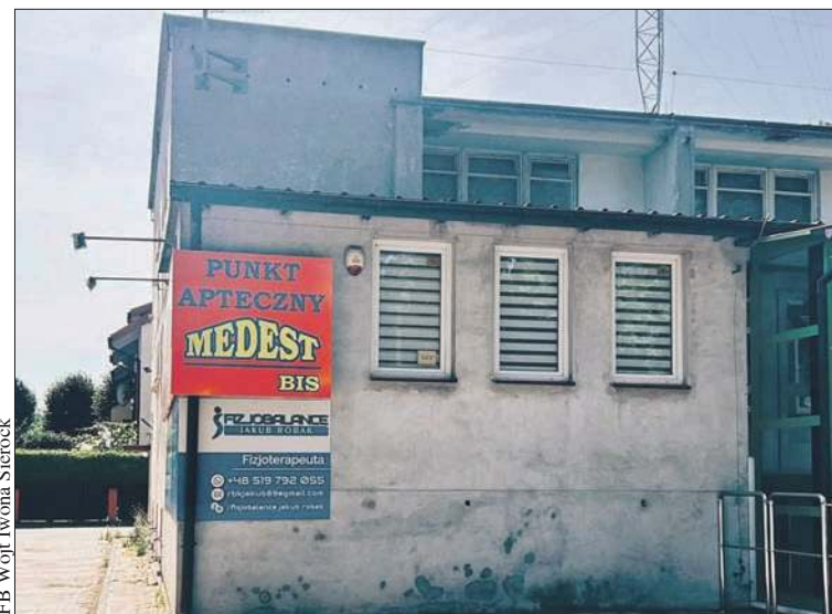
Budynek po byłym Ośrodku Zdrowia w centrum Łącka wkrótce przejdzie modernizację
