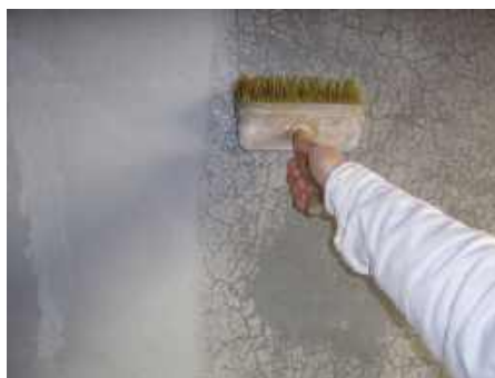
Preparat gruntujący nanosi się na powierzchnię ściany za pomocą pędzla.
