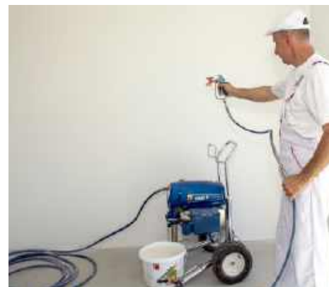
W przypadku wykańczania ścian od nowa, do tynkowania i malowania najwygodniej użyć agregatu. BAUMIT
