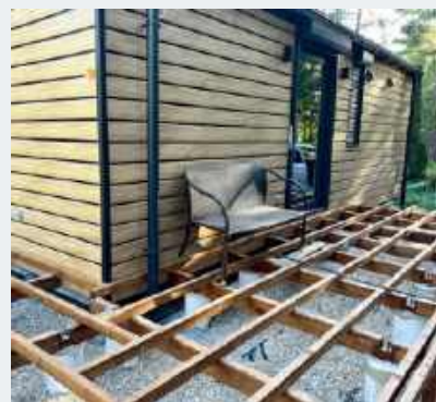
Stopy fundamentowe, legary świerkowe, na gruncie geowłóknina i otoczaki.
