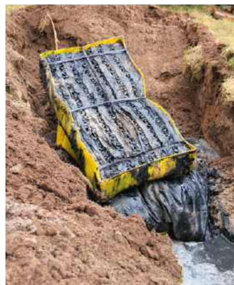
🔧 Ścieki stojące na drenażu i zamulone skrzynie drenażowe z tworzywa. J. WERNER
