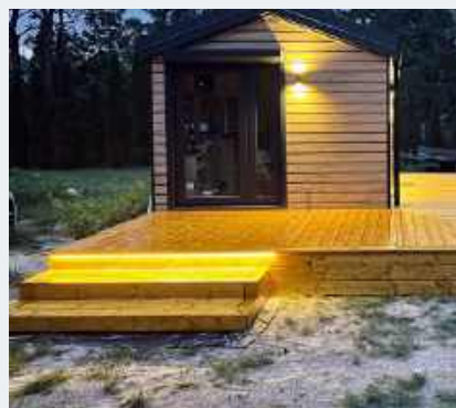
Na podeście o wysokości 70 cm, zastosowano deski nieryflowane.
