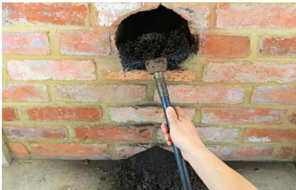
🔦 Przegląd kominiarski obejmuje nie tylko czyszczenie kanałów kominowych ale również ocenę ich stanu. ADOBE STOCK
