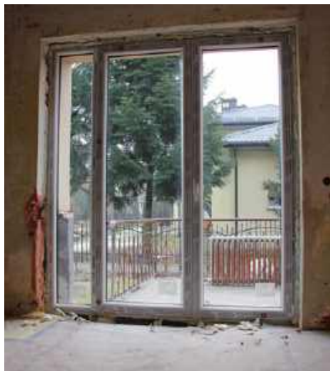
❶ Przy kompleksowej termomodernizacji rozpoczynamy od wymiany stolarki. J. WERNER
