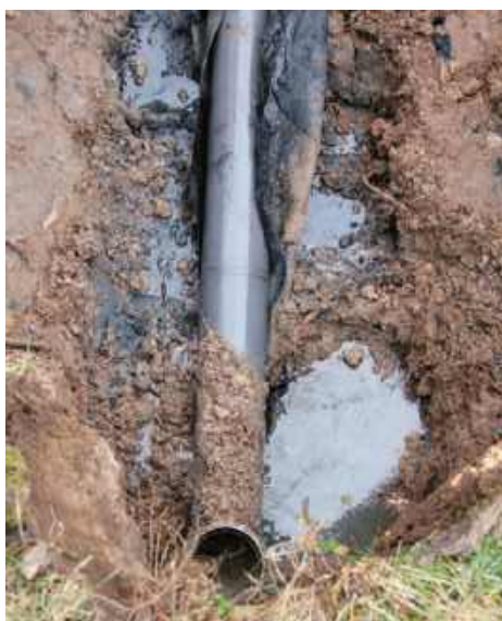
🔧 Ścieki stojące na drenażu i zamulone skrzynie drenażowe z tworzywa. J. WERNER
