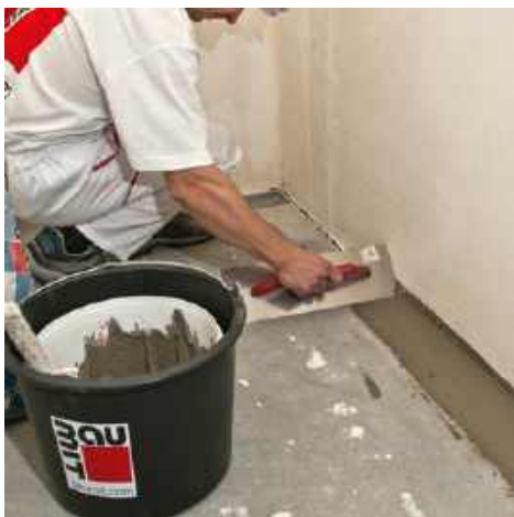
🔧 Staranne wyrównanie podłoża to istotna czynność przed ułożeniem płytek podłogowych. BAUMIT
