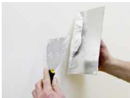
Zaprawę nakłada się nierdzewną pacą.
