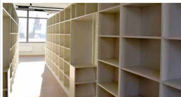
W zmodernizowanej Książnicy montowane jest już nowe wyposażenie
