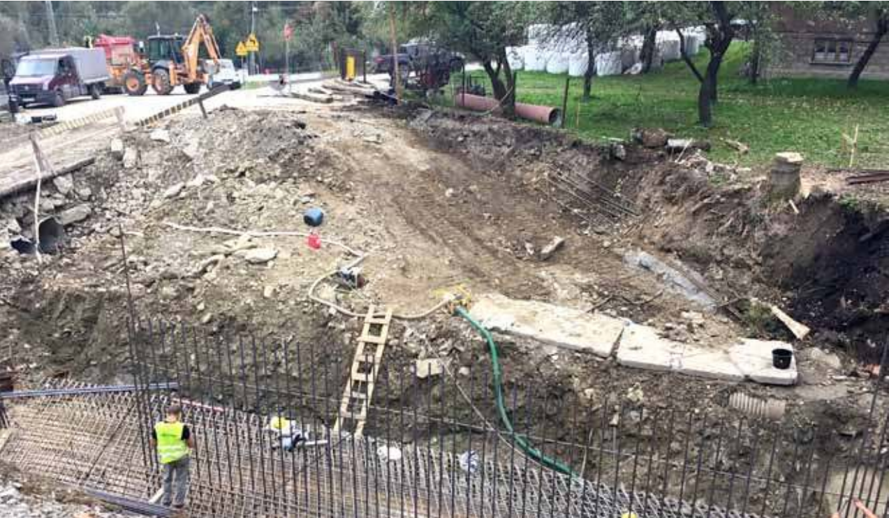
Utrudnienia związane z budową mostu potrwają jeszcze miesiąc.
