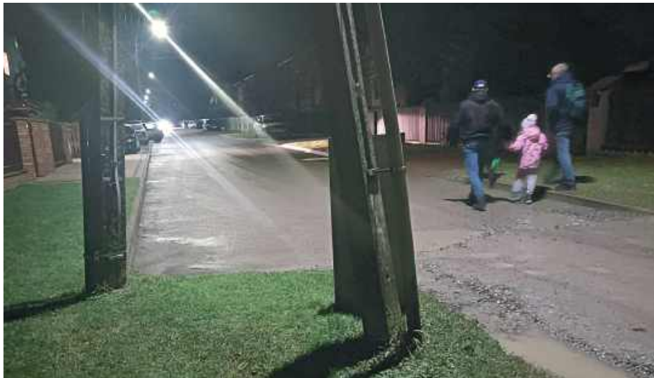
Słup należący do PGE uniemożliwia prace na drodze
