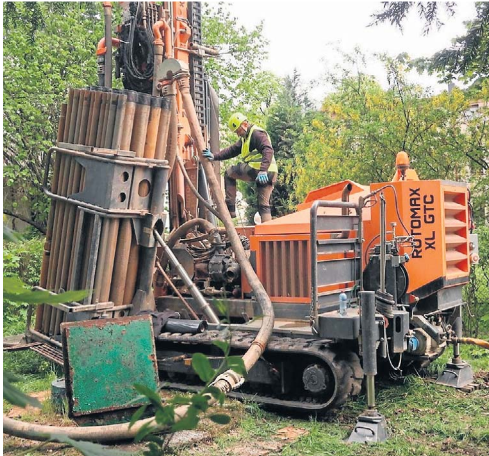
Odwiert już ruszył. Dzięki niemu wydobycie wody źródlanej będzie zwiellokrotnione.
