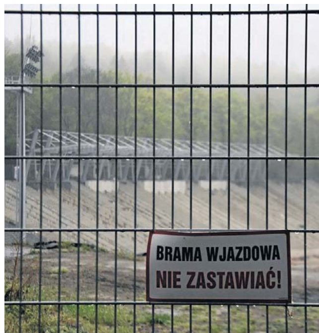
Zamknięte bramy, rozkopany teren, brak jakichkolwiek prac. Remont stadionu miał się zakończyć w 2025 roku...
