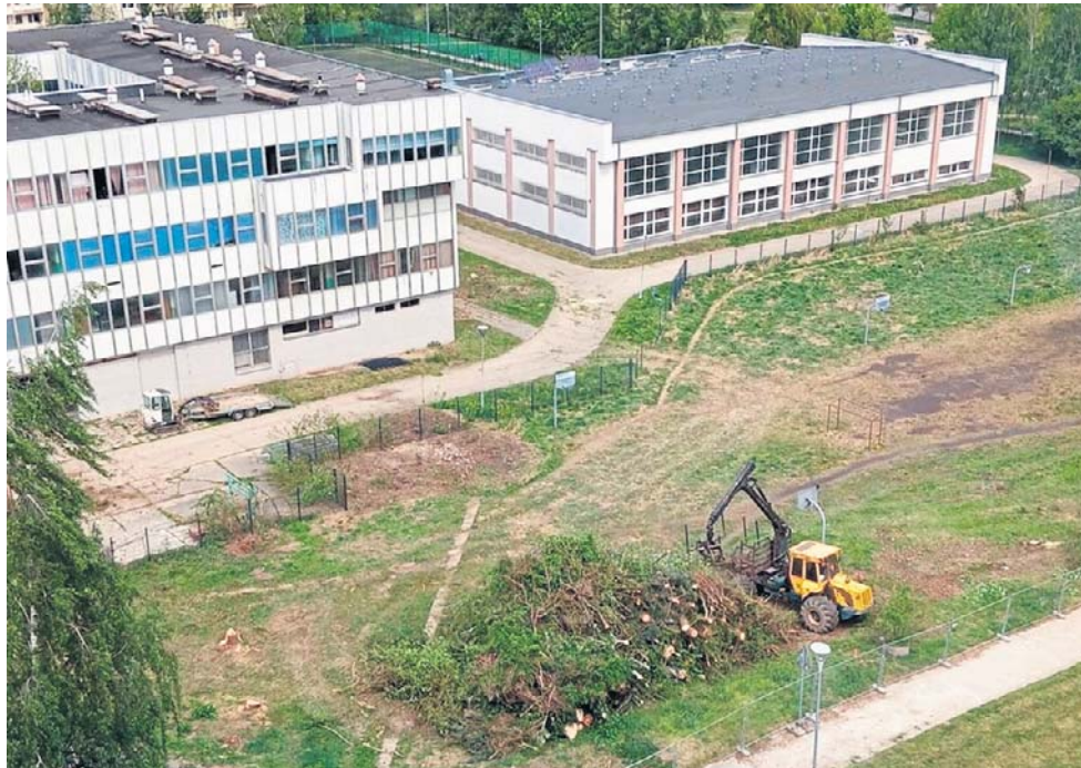
Trwa wycinka drzew w okresie lęgowym na placu budowy nowej szkoły na Podzamczu.
