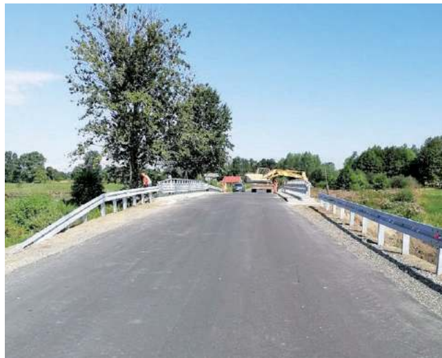
Przebudowa obiektu mostowego na rzece Szyszla.
