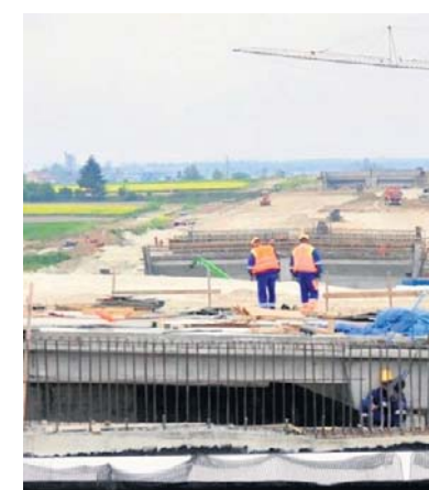
Budowa trasy S17 została podzielona na odcinki
