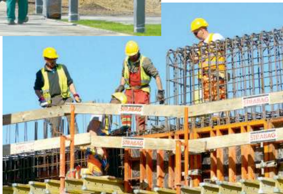
Pracują drogowcy i budowlancy.
