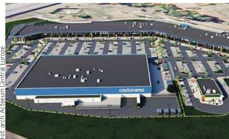
Tak ma wyglądać już w przyszły rok Ostróda Power Center
