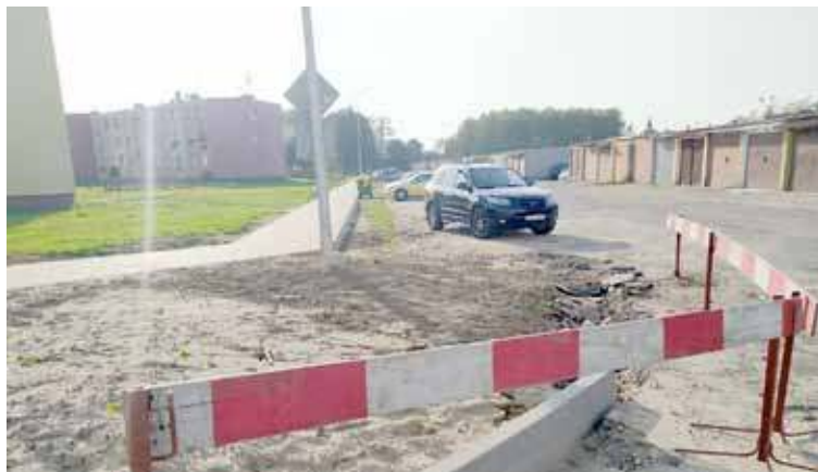
Jeszcze tydzień temu na terenie Leśnej widać było maszyny budowlane. W tym tygodniu pozostały tylko oznaczenia terenu robót
