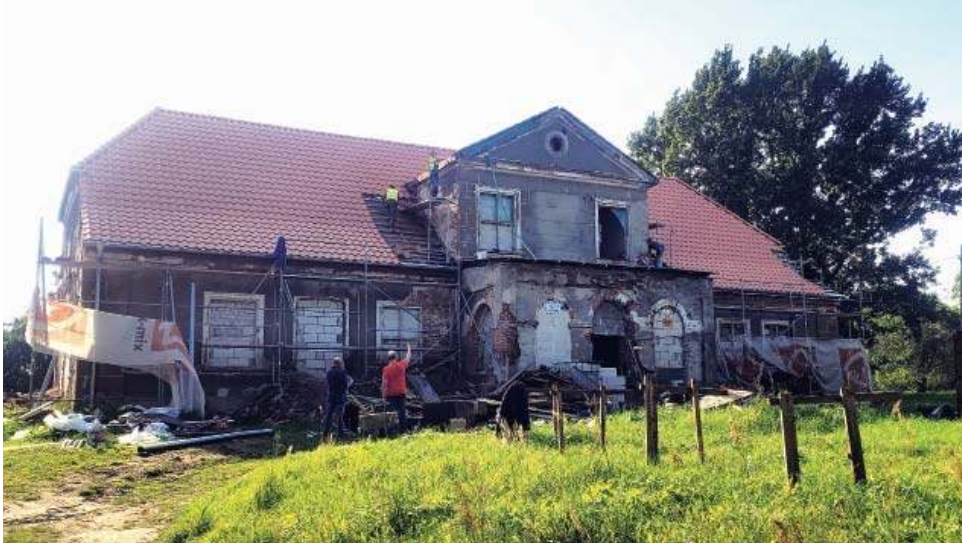
Dworek Beliana w trakcie wymiany dachu
