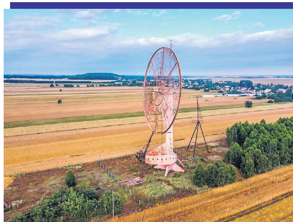
Konstrukcja na polu w podkłobuckiej wsi ma 54 metry wysokości. Jest lokalną atrakcją, ale także dowodem na to, że można i trzeba marzyć.
