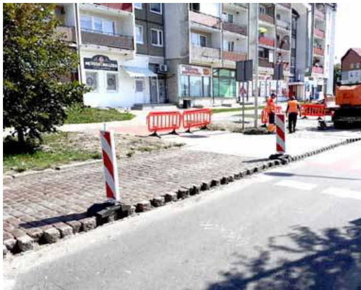
Aby zwiększyć bezpieczeństwo pieszych na ulicy Armii Krajowej powstanie wyniesione przejście dla pieszych
