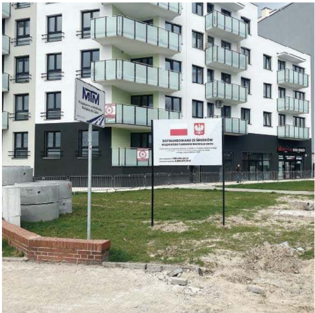
Trwają prace dotyczące połączenia ul. Związku Jaszczurczego z al. Grunwaldzką. Koszt realizacji zadania to 3,8 mln zł, z czego prawie 2 mln zł to środki pochodzące z Rządowego Funduszu Rozwoju Dróg
