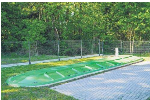
Budowa oczyszczalni ścieków w miejscowości Chwalimki
