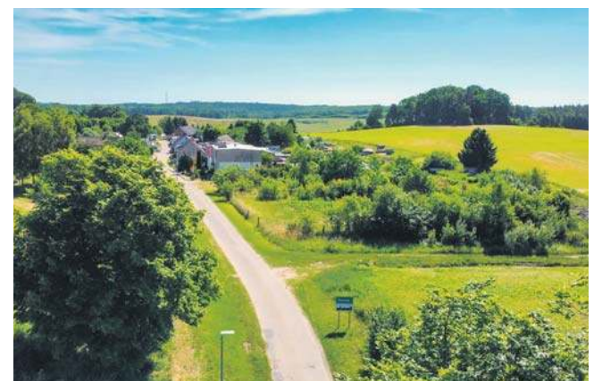
Przebudowa drogi do miejscowości Tarmno
