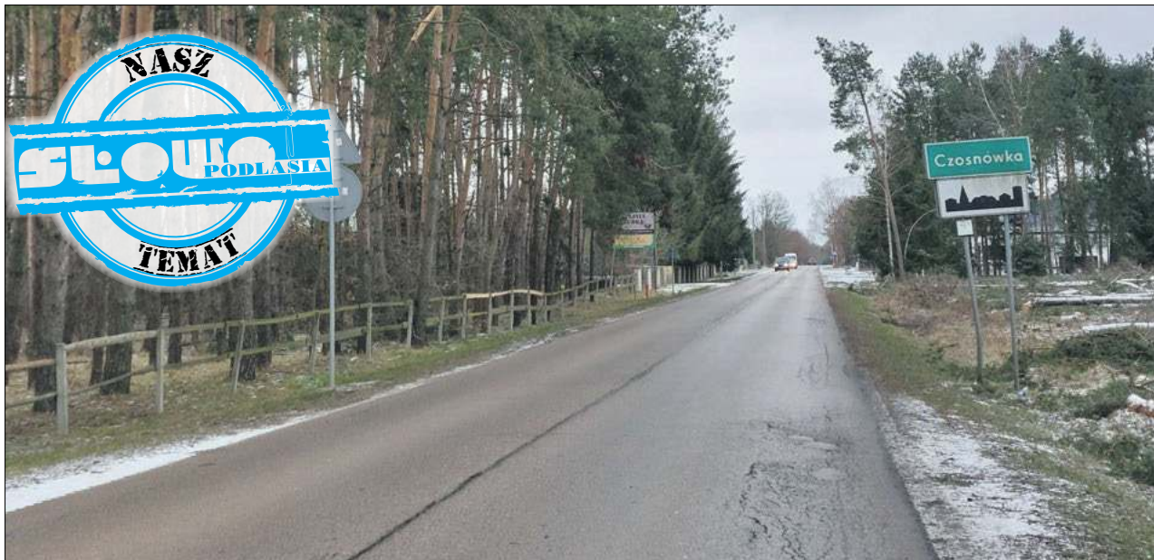
Mieszkańcy Czosnówki w końcu doczekają się chodnika i ścieżki rowerowej na odcinku prawie 4 km
