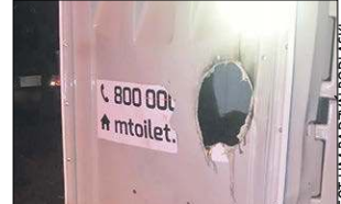
Zniszczeniu uległy drzwi i wnętrza kabin. Straty to 15 tys. zł
