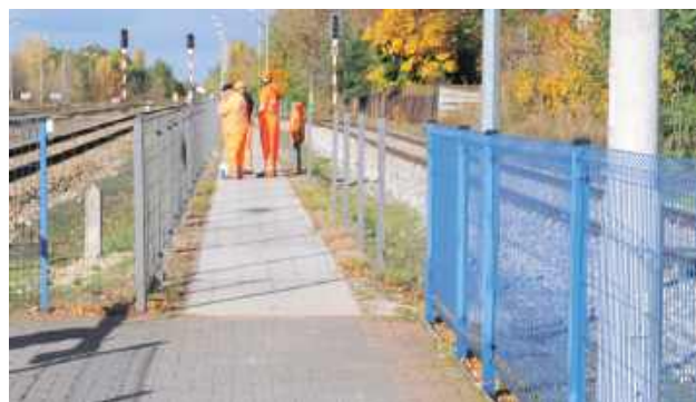
Ekipa rozbierająca przejście pojawiła się 28 października
