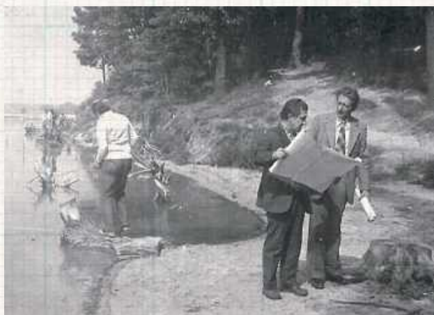
Wyznaczanie terenów pod budowę Zalewu Zemborzyckiego, lata 70. XX wieku
