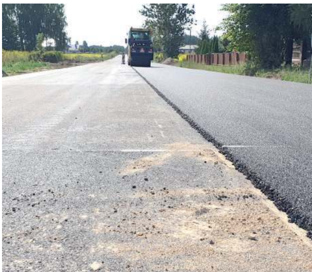
Budowa drogi Kozłówka - Dąbrówka I etap
