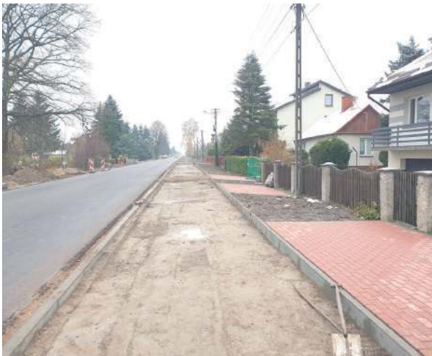
Budowa drogi w Nowej Jedlance
