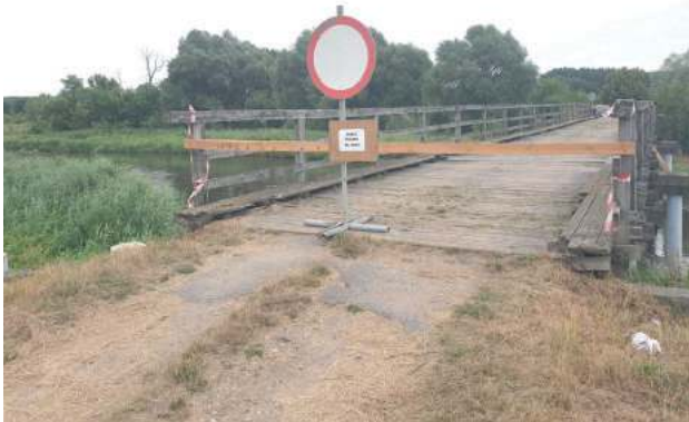
Zamknięcie mostu na Wieprzu w Luszawie
