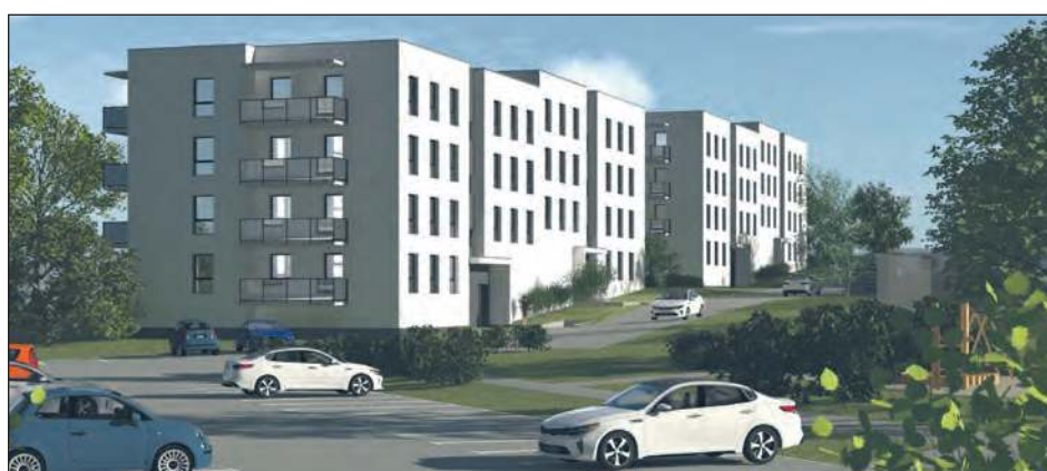
Inwestycja zlokalizowana będzie w południowej części Ryk przy ulicy Granicznej. Planuje się budowę dwóch budynków czterokondygnacyjnych z podpiwniczeniem, po 32 mieszkania w każdym
