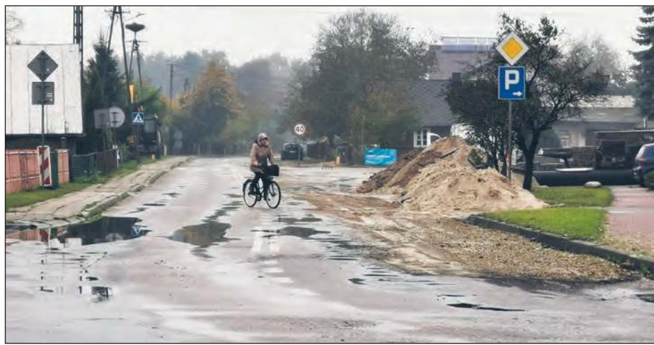
Został już wybudowany kolektor burzowy, który rozwiąże problem zbierającej się wody w tym miejscu - podkreśla Marcin Kostyra, dyrektor Zarządu Dróg Powiatowych w Rykach. W połowie listopada na drodze ma się też pojawić pierwsza warstwa asfaltu
