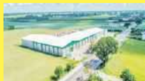
Nowoczesna hala przemysłowa o łącznej powierzchni 3 150 m 2 usytuowana na działce hektarowej w miejscowości Wołyń, 885 851 172
