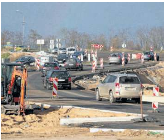
Pod koniec listopada oddano do ruchu ulicę Granitową, ale na finał prac musimy poczekać kilka miesięcy
