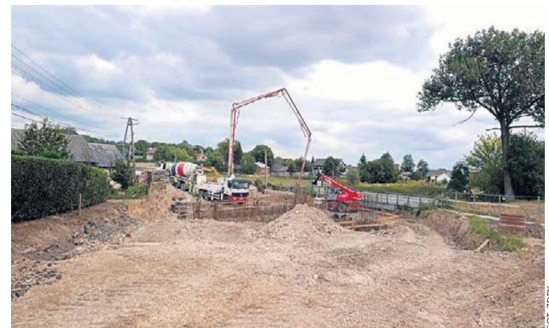
Konieczne było wykonanie pali pod przyczółki mostu
