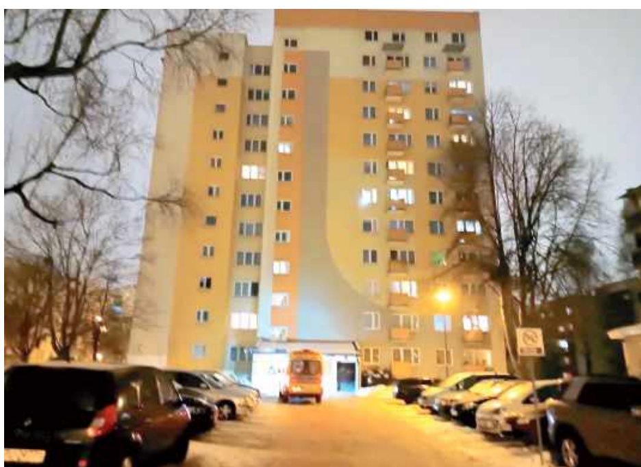
To właśnie w tym wieżowcu doszło do tragedii
