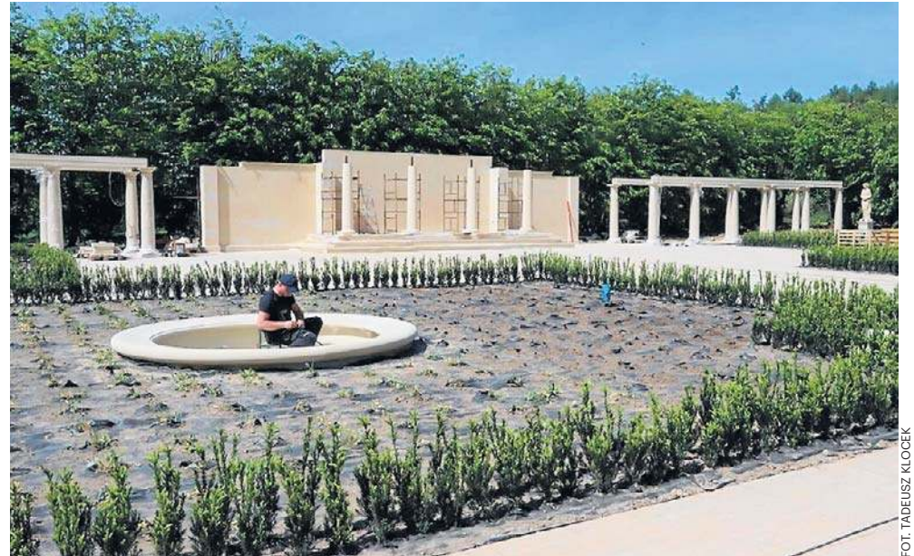
Trwa budowa Ogródu Fontann przy Pałacu Mała Wieś; uroczyste otwarcie odbędzie się 16 czerwca.
