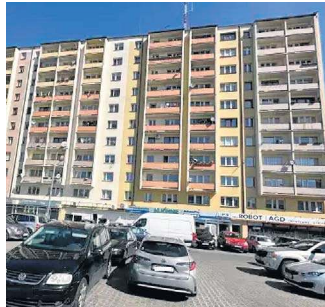
W bloku przy ulicy Niedziałkowskiego 19/21 nowoczesne windy będą w tym roku w trzech klatkach.
