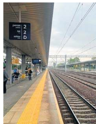
Niedawno odnowiono linię Radom - Warszawa.
