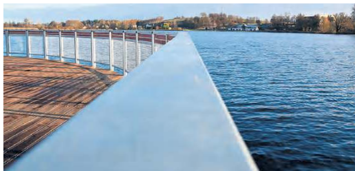
Początkowo balustrady na pomoście miały być drewniane. Ostatecznie zdecydowano się jednak na połączenie metalu i drewna.
