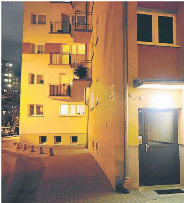
Do zdarzenia doszło na klatce schodowej w budynku przy ul. gen. Maczka.
