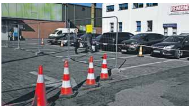
Na parkingu przy CHU w Tarnowskich Górach prowadzone są prace związane z montażem carportów
