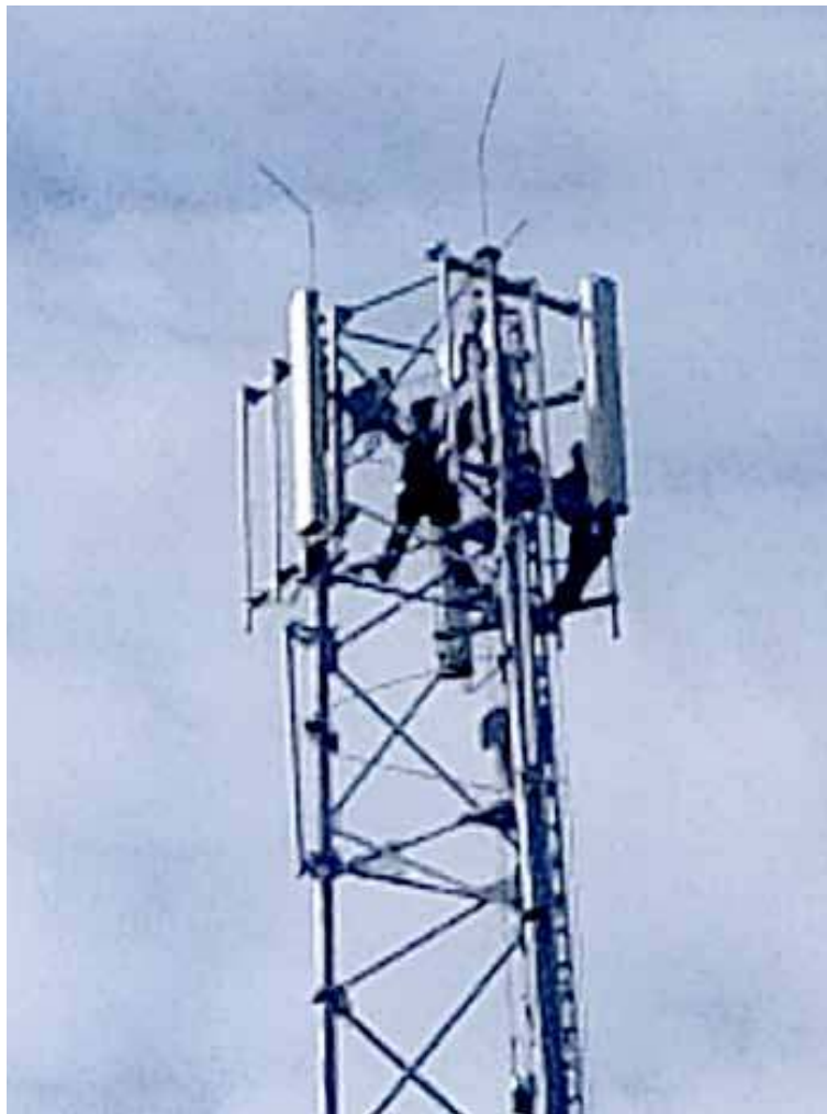
W czwartek w Wojcieszynie - trwa montaż „na górze”
