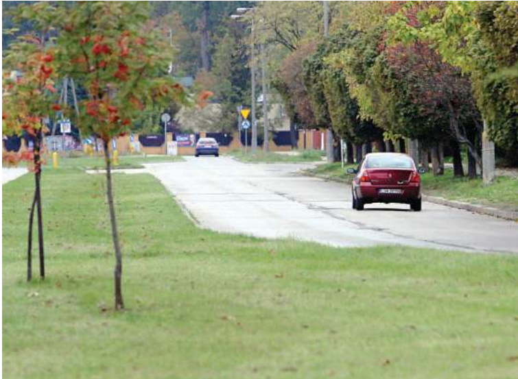
Nawierzchnia miejskiego odcinka ulicy Raławickiej zostanie naprawiona
