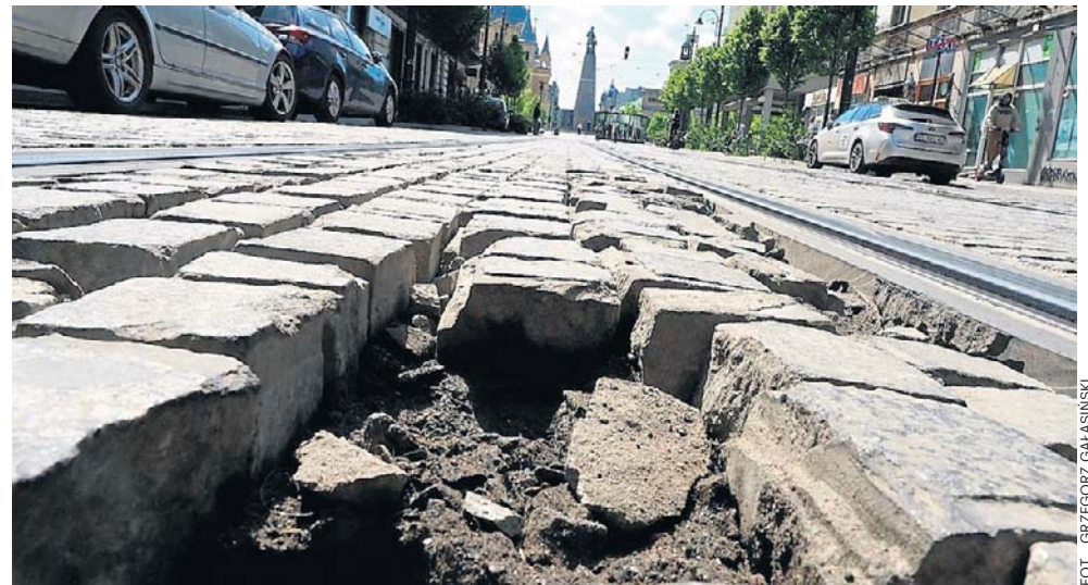
Kostkę granitową na pl. Wolności i na dochodzącej do niego ul. Nowomiejskiej położono zaledwie dwa lata temu...
