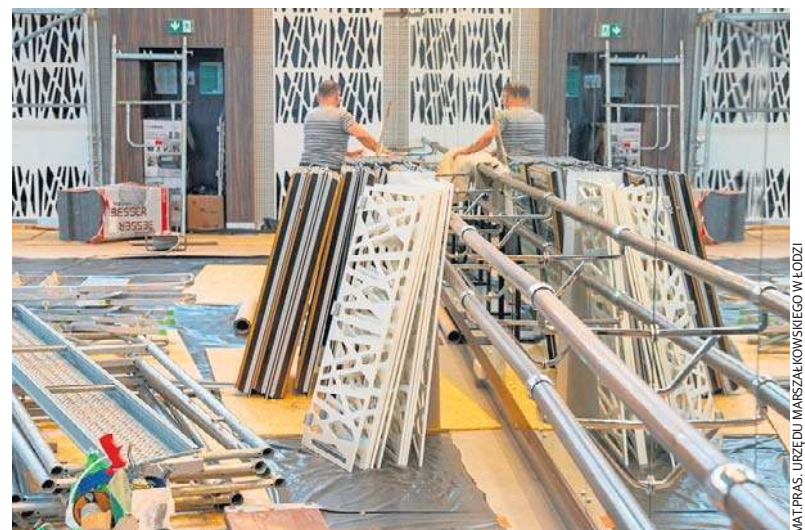
Modernizacja nie ograniczy się wyłącznie do prac budowlanych. Projekt przewiduje organizację 28 szkoleń dla 450 pracowników.
