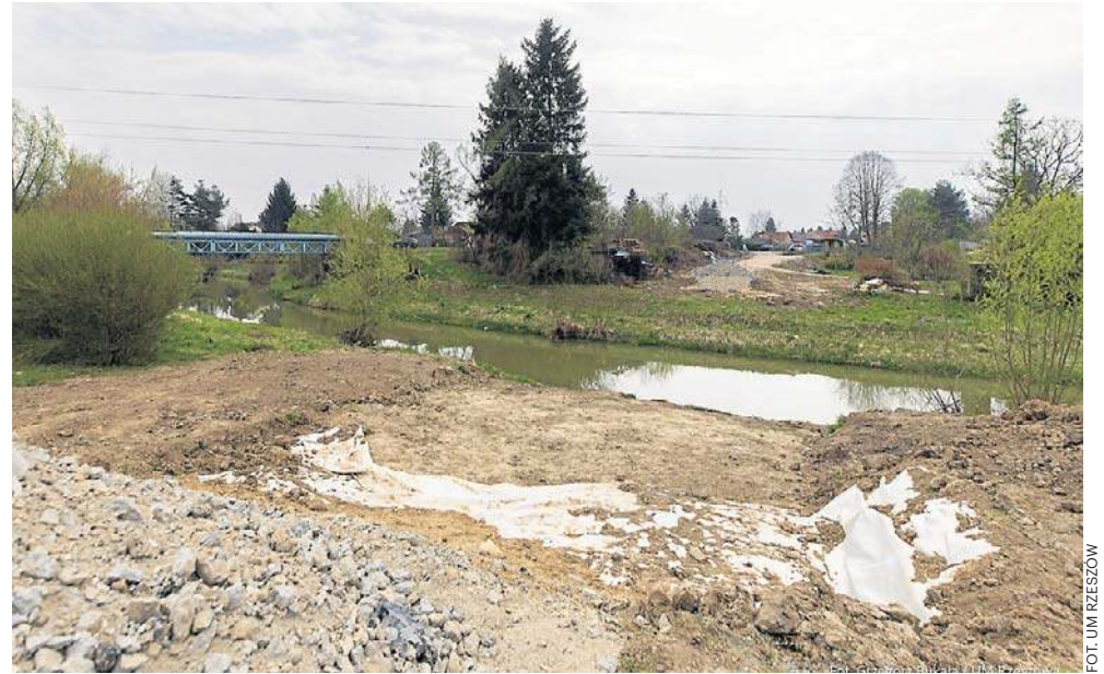
Trwające teraz roboty na os. Drabinianka mają umożliwić wzmocnienie koryta rzeki Strug w miejscu, gdzie powstanie kładka dla pieszych i rowerzystów.
