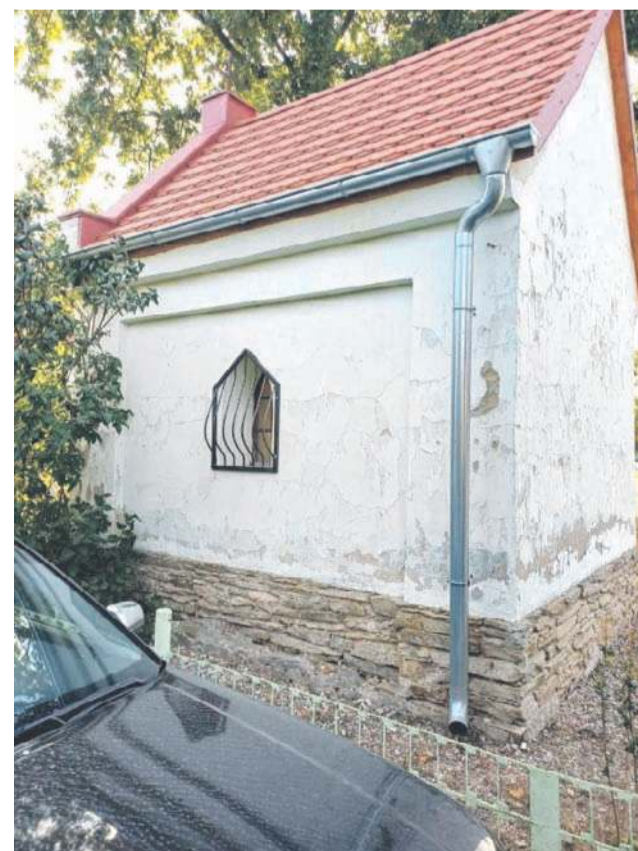
Elewacja kapliczki przed renowacją
