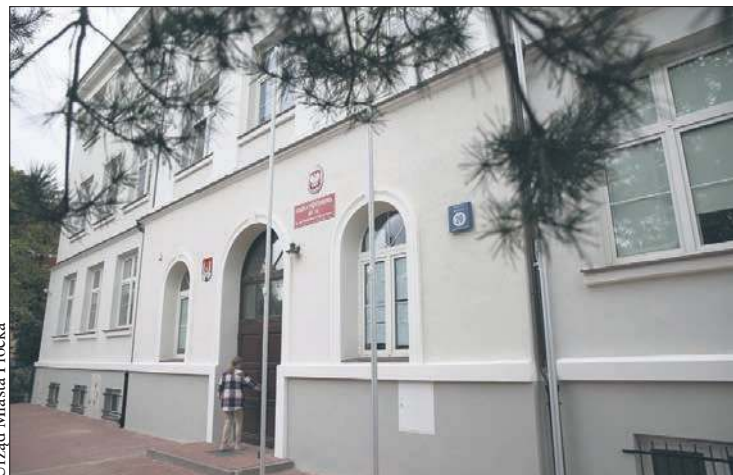
Elewacja SP 14 po remoncie
