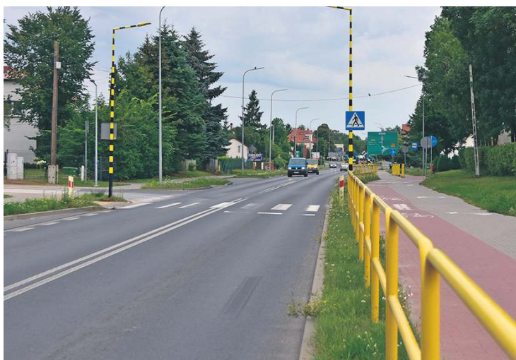
Jadąc z Rudzkiego Mostu w kierunku centrum Tucholi, po prawej stronie widać jedynie ciąg barierek. W okresie zimowym, widoczność w obrębie przejścia dla pieszych na ulicy Świeckiej jest znacznie gorsza. To właśnie w tym czasie, na widocznym przejściu najczęściej dochodzi do potrąceń.
