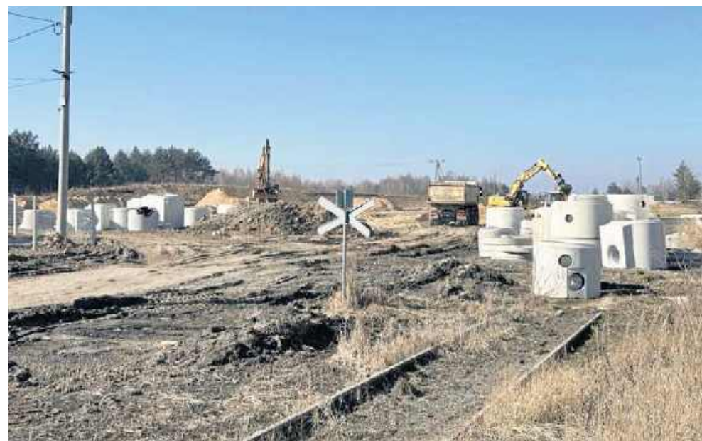
Ruszyły prace przy budowie terminala przeładunkowego na terenie po byłej Elektrociepłowni Radom. Powstaje na przedłużeniu nieużytkowanej przez lata bocznicy,
