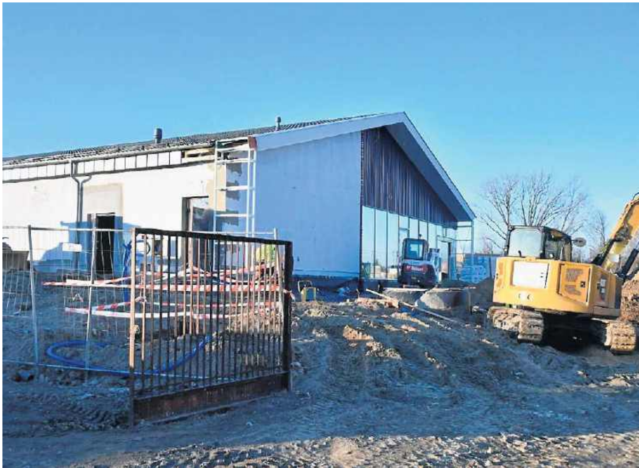
Biedronka u zbiegu ulic Nowowiejskiej i Przemysłowej w Pińczowie ma być gotowa już wiosną 2026 rok.
